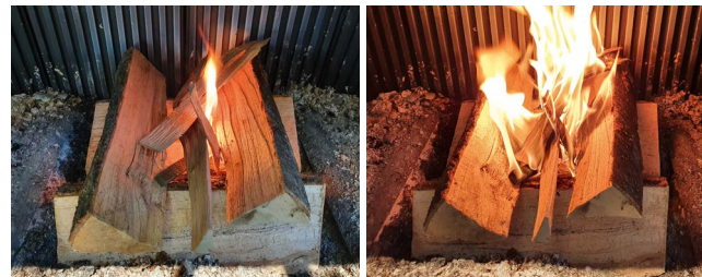
Perfekter Anzündvorgang in Feuerraummulde mit Anzünder und Anzündhölzern zwischen der oberen Holzlage.
